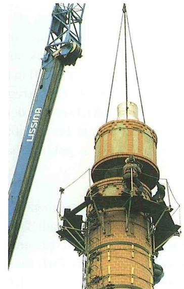
**Bild 1.4:** Einbau des Edelstahlrohrs
